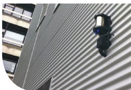
Anwendungsbeispiel: Referenznullpunkt montiert an Gebäudeaußenwand
